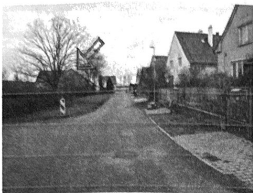
Pohled JV po přístup. komunikaci v úseku p. č.408/34
